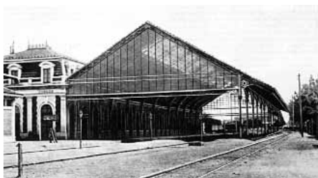
Andenes de la Estación cubiertos por una marquesina acristalada. (C. Sáinz Varona).
